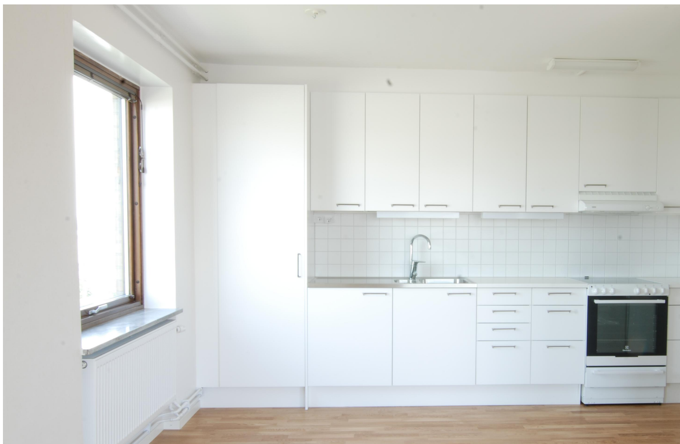
Referensbild ombyggt kök
